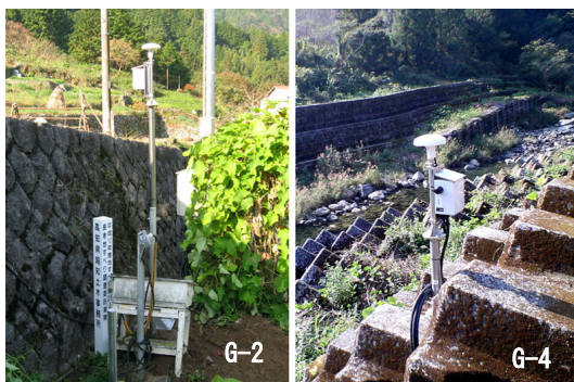
写真-1 GPS 計測機器の設置状況
